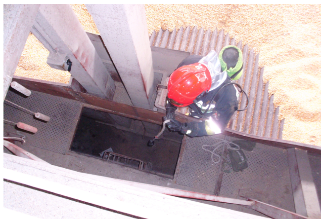
Photo 1. Technological shaft in a grain dryer Fot. 1. Szyb technologiczny suszarni zboża
