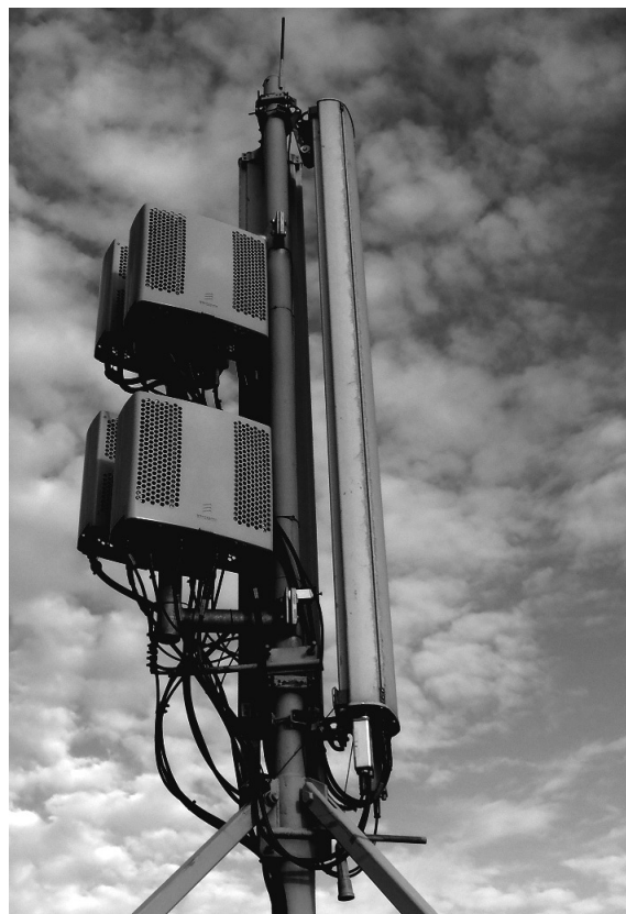
Fot. 2. Stacja bazowa z „plecakowymi” modułami radiowymi Photo 2. The base station with small remote radio units
